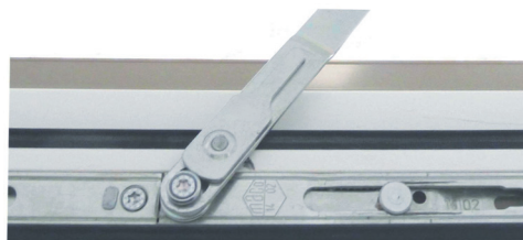
Öffnungsbegrenzer eingehängt, Sicherungshebel geschlossen
