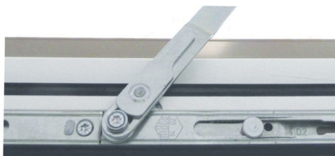
Öffnungsbegrenzer eingehängt, Sicherungshebel geschlossen
